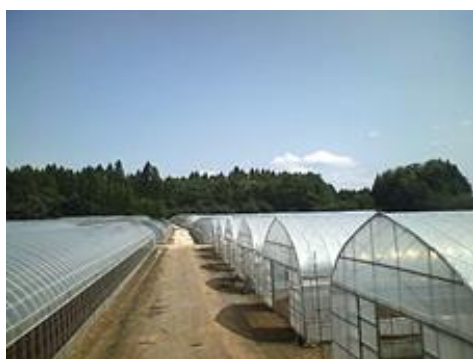
写真：ハウス全体の外観
